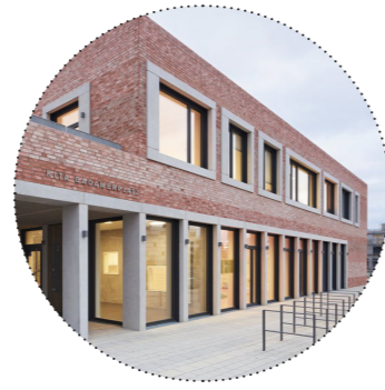
Betonnen lateien geven een accent aan de raamkaders.
