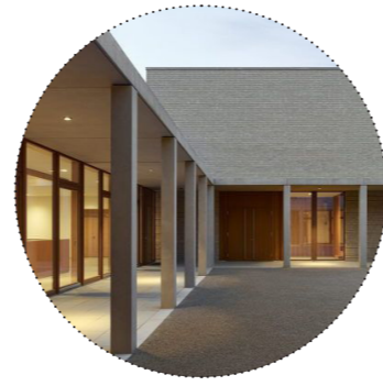
Collonade bij teruggelegde plint zorgt voor een droge entree, en een droge verbinding met de gymzaal.
